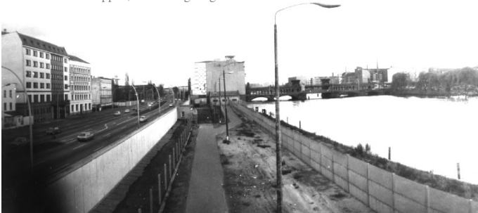
Grenzanlage an der Mühlenstraße, Blick nach Südosten, 1988. Foto der Grenztruppen, Sammlung Hagen Koch
